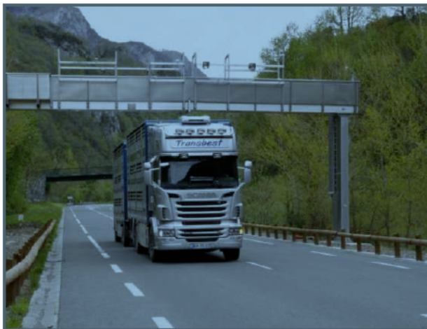
Deux portiques avaient été installés pour les besoins de l'écotaxe sur la RN 134 entre le col du Somport et Pau (ici à Borce), en Béarn. Ils n'ont jamais servi. MARCEL BESANÇON / ARCHIVES SUD OUEST
